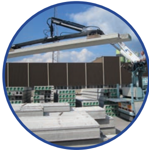
Handling van betonnen vloeren
