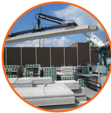
Handling van betonnen vloeren
