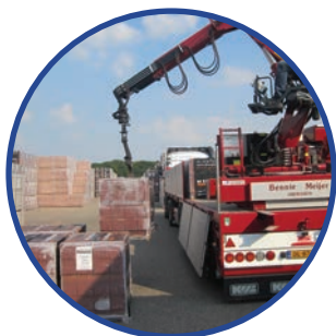
Handling van bakstenen en blokken
