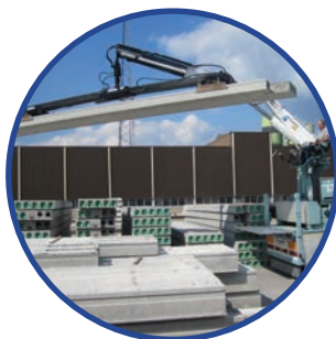
Handling van betonnen vloeren
